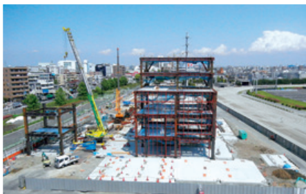
工事の状況（2015年5月撮影）
